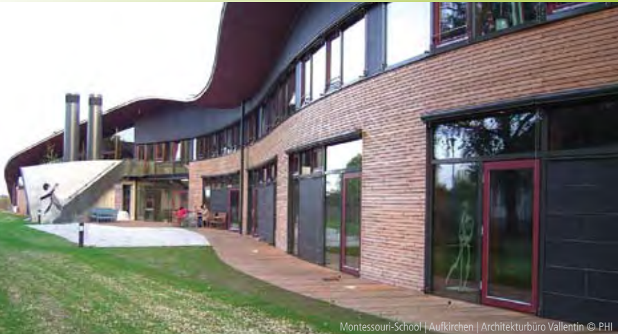
Montessori-School | Aufkirchen | Architekturbüro Vallentin © PHI
